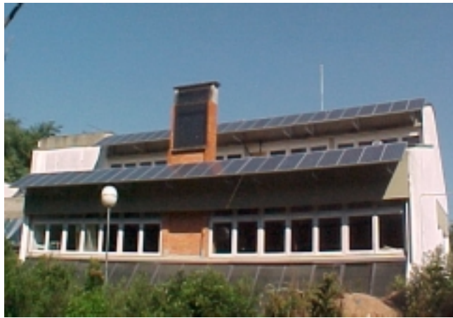
Figura 1 - Módulos instalados no Laboratório de Energia Solar da UFRGS.
