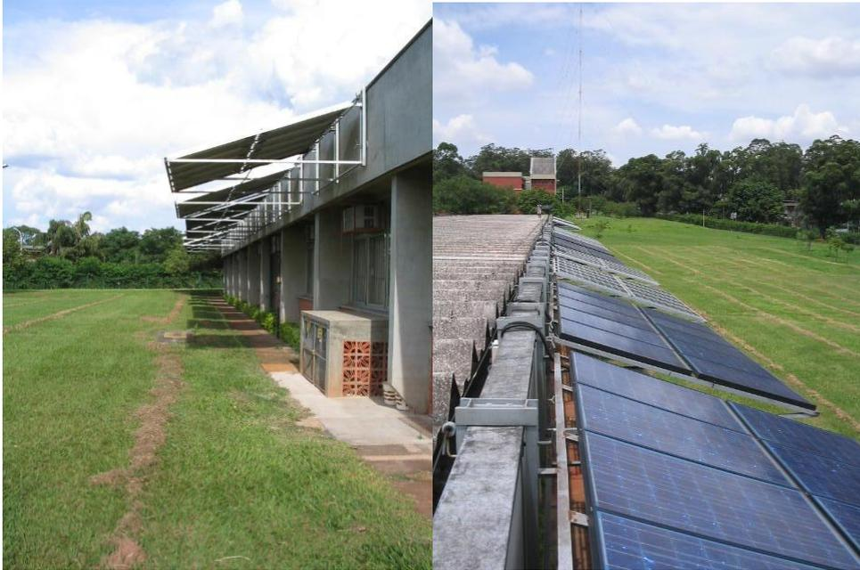
Figura 1- Geradores instalados na fachada do prédio da administração do IEE/USP.
