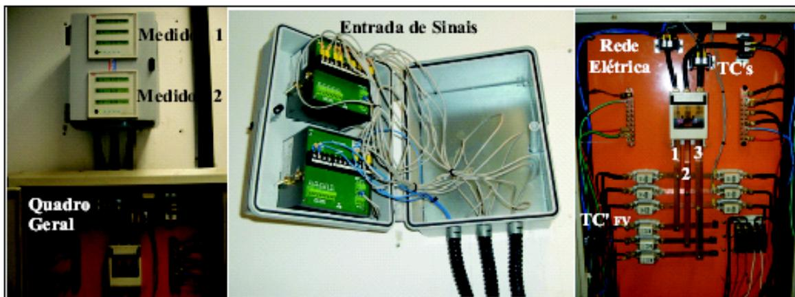
Figura 4- Etapas da instalação dos equipamentos utilizados no processo de medição das grandezas elétricas.
