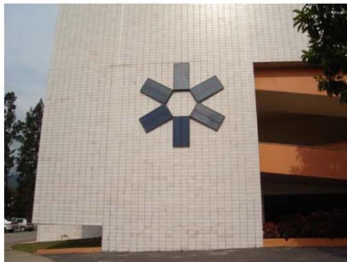
Figura 8 - Painel fotovoltaico do sistema de iluminação de emergência do CCEven.
