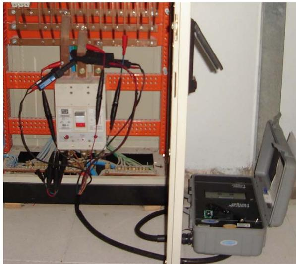
Figura 3 - Medidor-registrador *Rustrak* instalado no quadro geral de distribuição do CCEven.
