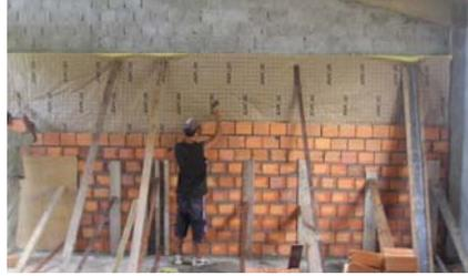
Figura 6.1 – Colocação do isolante térmico na parede dupla.
