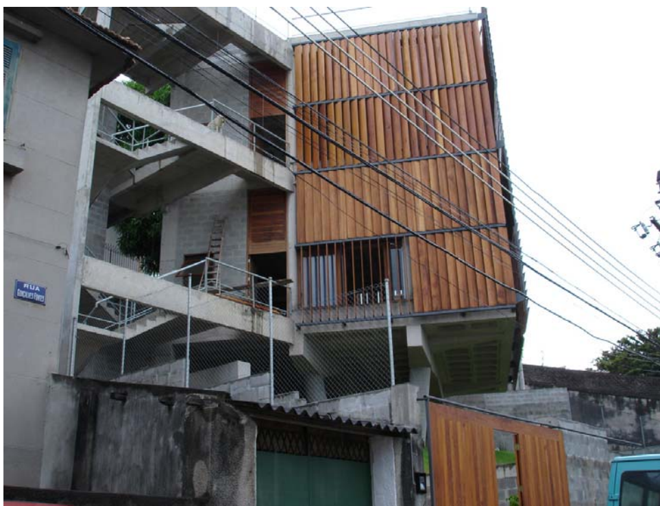
Figura 7 - Imagem final: volume principal – fachada leste com sistema de brises-soleil articulado.
