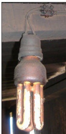
Figura 6- Aspecto de uma lâmpada exposta à fumaça e a solução encontrada. [Fotos: Federico Morante]
