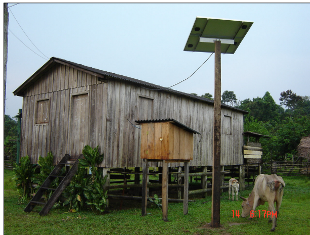
Figura 3. Vista externa de um domicílio da comunidade com SFD instalado. [Foto: André Mocelin]
