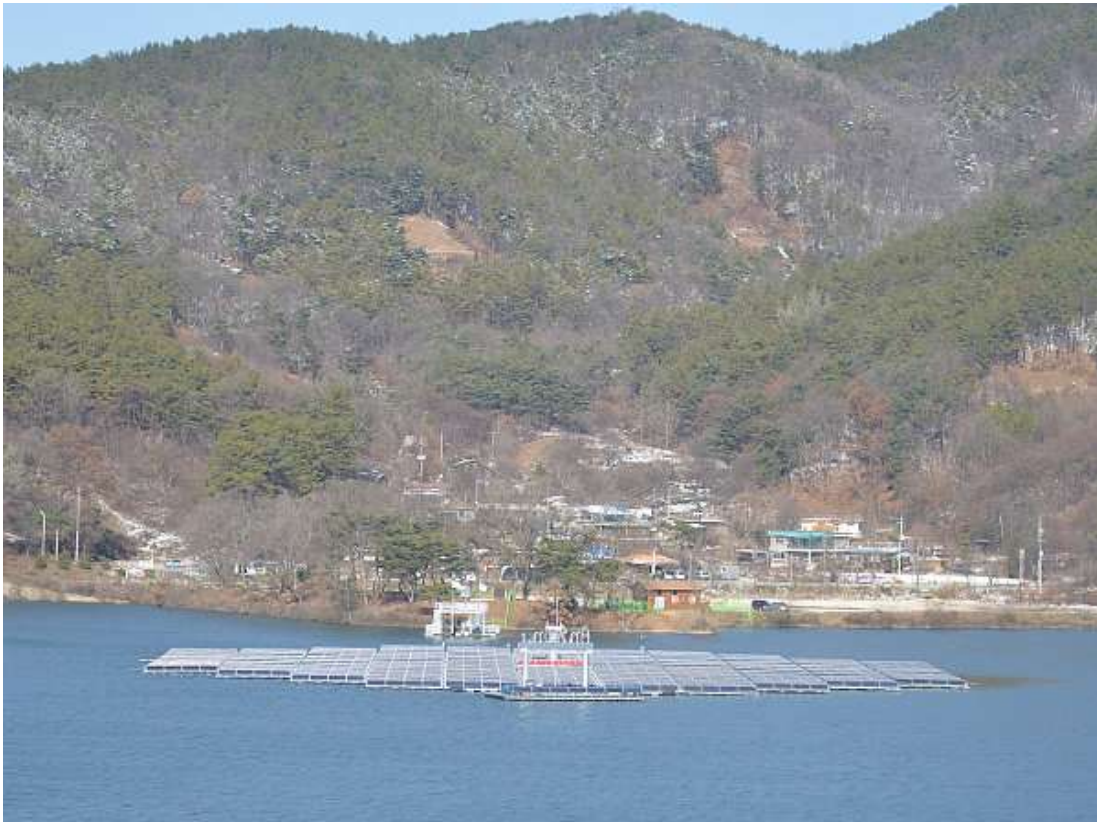
Figura 2 – Planta FV flutuante com rastreamento solar na Coreia (Fonte: SolarPark Korea)
