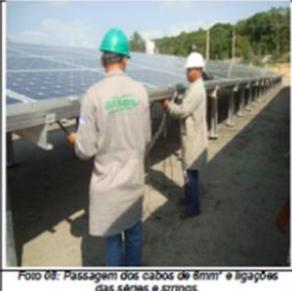
Foto 08: Passagem dos cabos de 6mm<sup>2</sup> e ligações das séries e strings.
