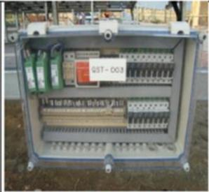
Foto 02: Montagem das estruturas suporte e dos strings box – Sistema Campo 03.
