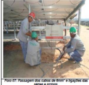
Foto 07: Passagem dos cabos de 6mm<sup>2</sup> e ligações das séries e strings.
