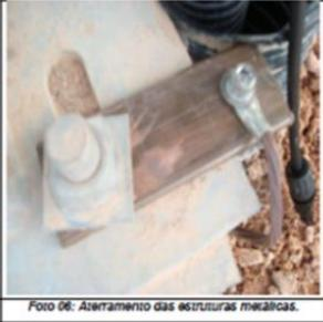
Foto 06: Aterramento das estruturas metálicas.
