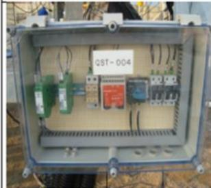
Foto 03: Montagem das estruturas suporte e dos strings box – Sistema Campo 04.
