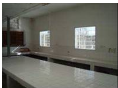
Figura 15- Foto del interior de la sala con iluminación desde ventanas norte.
