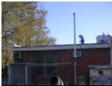
Figura 3- Construcción techo con aislación
