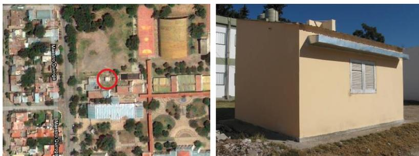
Figura 1- Izquierda, vista de la ubicación; Derecha, exterior de la fachada norte. Sobre la parte superior se ve el sistema anidólico; la ventana que se encuentra debajo fue clausurada.
