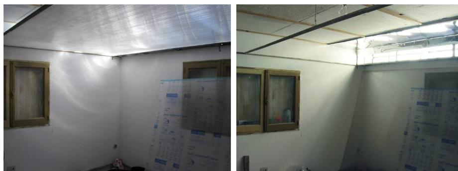
Figura 5- Situación interior con y sin cielo raso difusor (izquierda y derecha).
