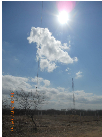
Figura 4. Torre com sistema de aquisição de dados Campus Petrolina Zona Rural
