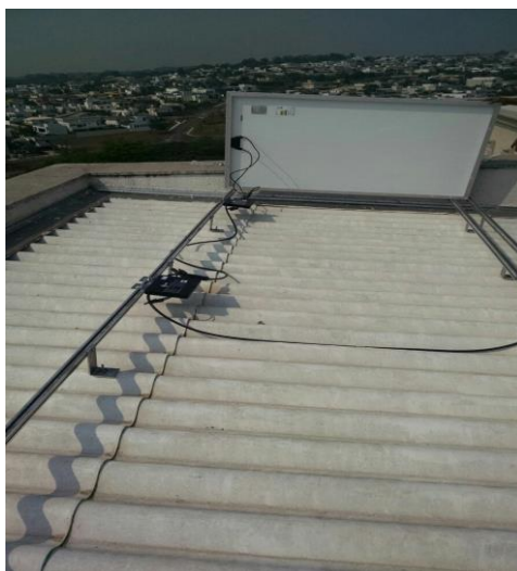
Figura 4: Instalação dos microinversores
