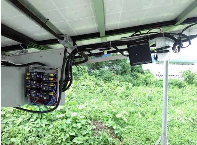
Figura 5- Sistema 1 após a instalação dos transdutores de grandeza elétrica.
