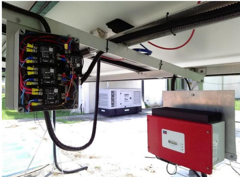
Figura 6- Sistema 2 após a instalação dos transdutores de grandeza elétrica.
