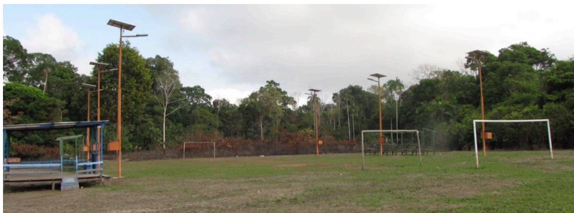
Figura 4- Iluminação de campo de futebol com energia Solar
