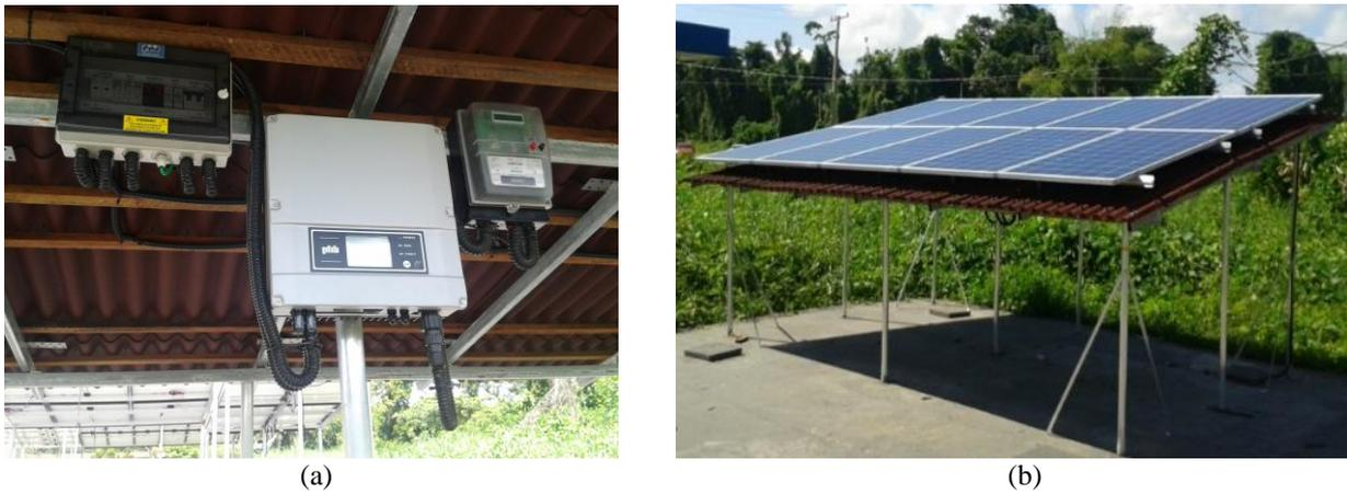
Figura 2 – Sistema A: (a) Disposição do inversor, caixa de proteção e medidor; (b) Vista geral do gerador FV sobre uma simulação de telhado e estrutura de sustentação.
