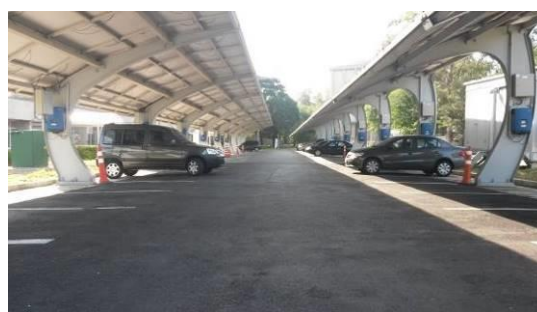
Figura 3 – Estruturas de suporte com módulos formando a cobertura do estacionamento do subsistema BIPV.
