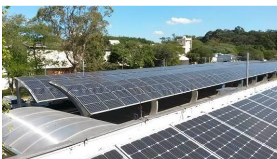
Figura 3 – Estruturas de suporte com módulos formando a cobertura do estacionamento do subsistema BIPV.
