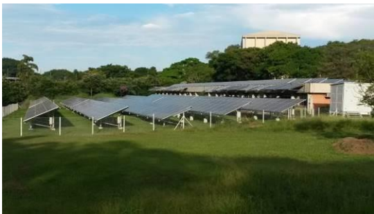
Figura 5 – Gerador fotovoltaico (esquerda) e eletrocentro (direita) do subsistema CTPV.
