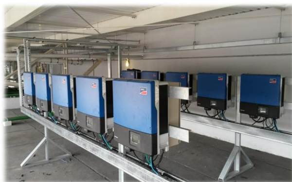
Figura 9 – Estruturas de suporte dos módulos (esquerda) e dos inversores / caixas de conexão (direita) do subsistema BAPV.
