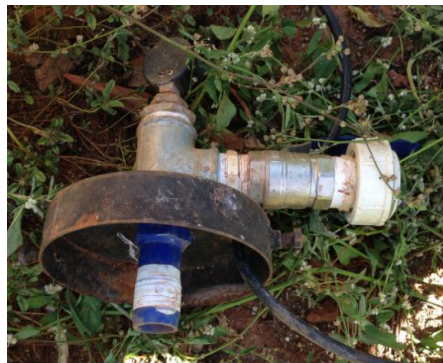
Figura 5. Detalhe da tampa da boca do poço com espigão plástico.
