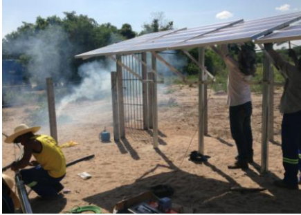
Figura 10. Utilização de fumaça para espantar marimbondos durante instalação da motobomba.
