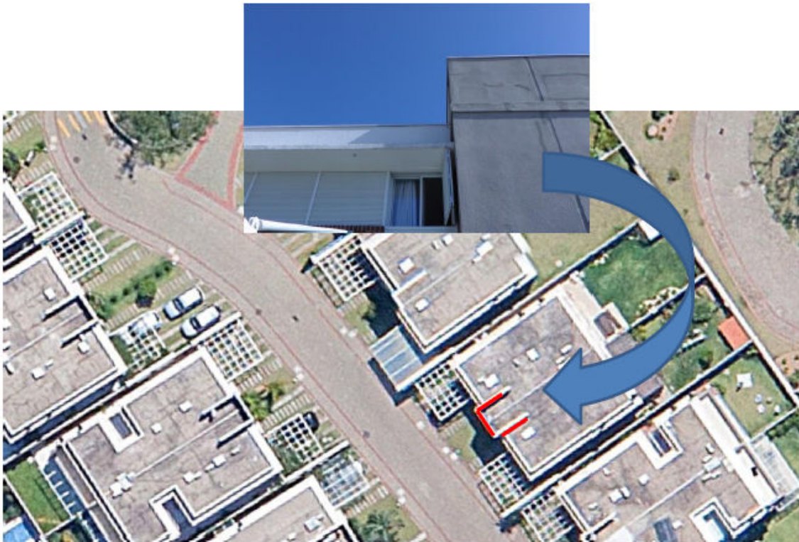
Figura 7 – Detalhe da cobertura das residências onde serão instalados os módulos fotovoltaicos.
