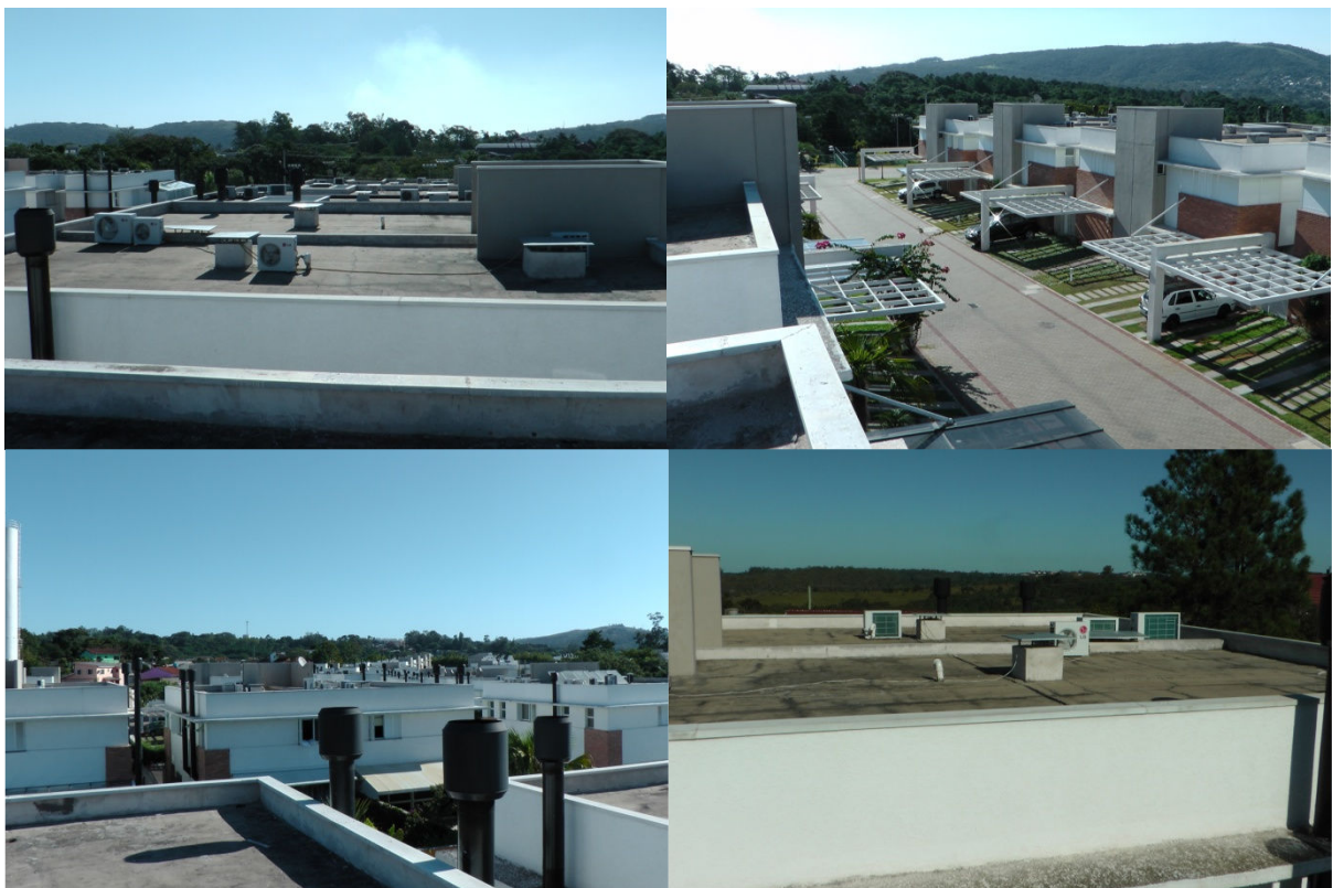
Figura 8 – Características do local de instalação dos telhados fotovoltaicos.
