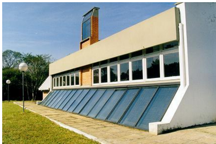
Figura 1 - Foto do laboratório de Energia Solar UFRGS com o coletor solar na fachada norte
