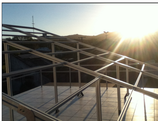
Figura 10 - Estrutura metálica montada.
