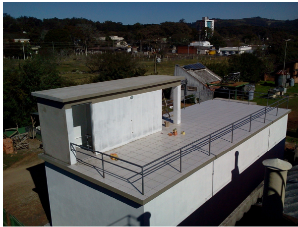
Figura 1 - Cobertura do novo prédio do LABSOL.
