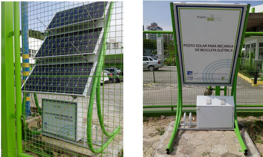
Figura 5 – Protótipo do posto de Recarga para Bicicletas Eléctricas instalado no IFSC.
