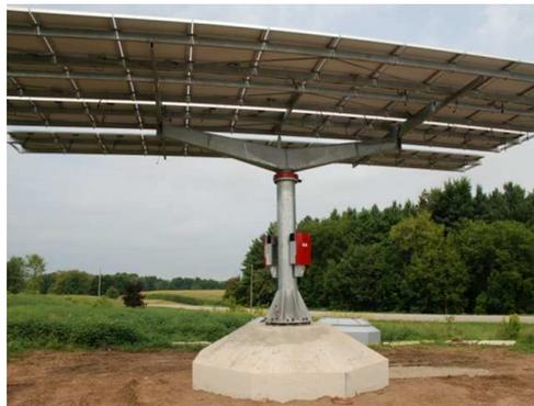
Figura 6 - Rastreador Solar de Eixo Duplo, Ontário Canadá. Adaptado de Ottawa Valley PhotoVoltaic (2013).
