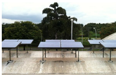
Figura 3 – Imagem dos doze painéis montados no teto do prédio do Centro de Pesquisas Hidráulicas da UFMG
