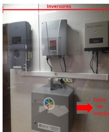
Figura 2 – Inversores das 3 micro UFVs conectados a caixa de junção (string).
