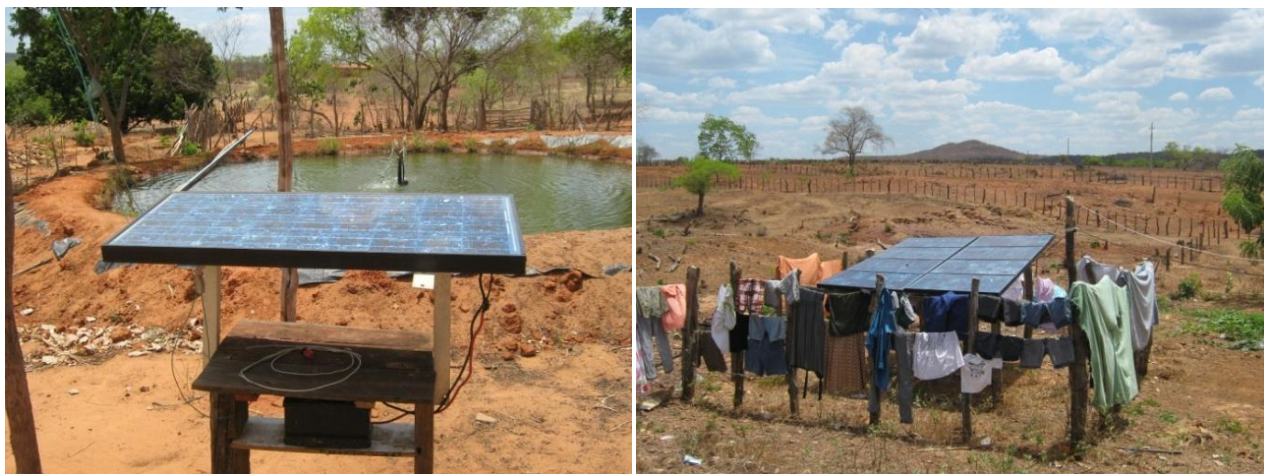
Figura 3 – Sistemas fotovoltaicos (aeração e domiciliar) na Comunidade Boca da Vereda, Oeiras (PI).
