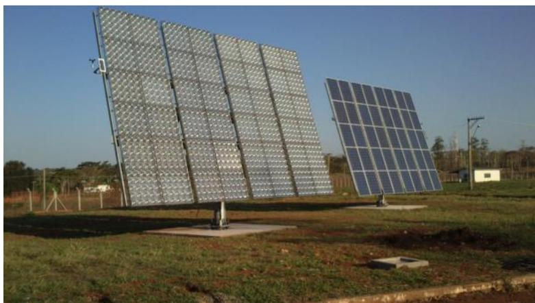
Figura 8 - Seguidores instalados no campus III da UNESP, com sistema com concentração à esquerda e com módulos planos à direita.
