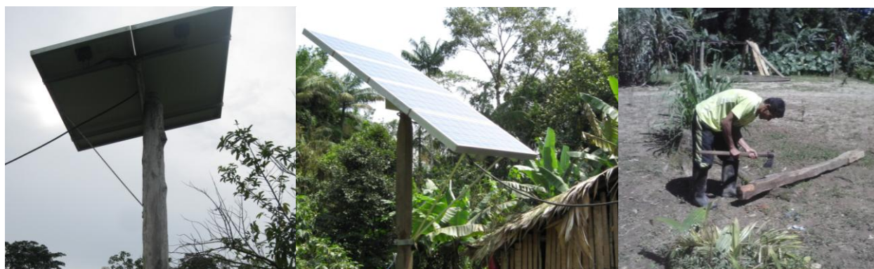
Figura 3 – Postes de madeira com suporte de alumínio (esquerda e meio) e processo de adequação do poste para o encaixe do suporte de alumínio.
