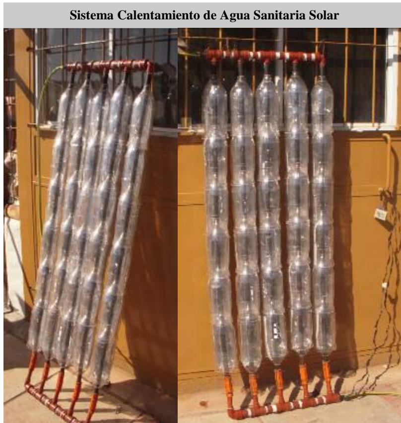
Figura 2: Imágenes del colector terminado con un Tanque de almacenamiento sin aislar.
