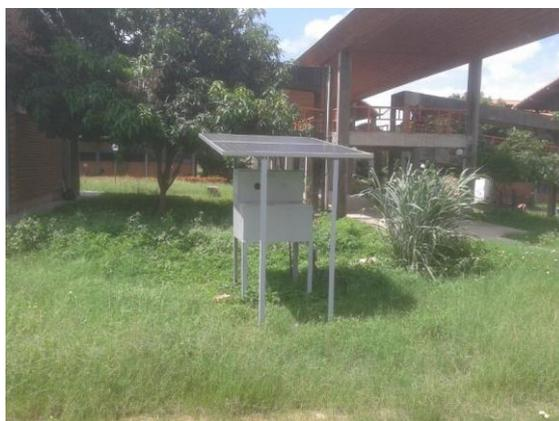
Figura 10 – Módulos fotovoltaicos instalados no kit fotovoltaico PRODEEM após a revitalização dos sistema.
