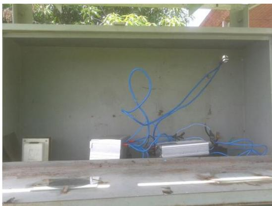
Figura 12 – Controlador de carga Phocos CX inserido no circuito após a revitalização do sistema. Fonte: acervo do autor.
