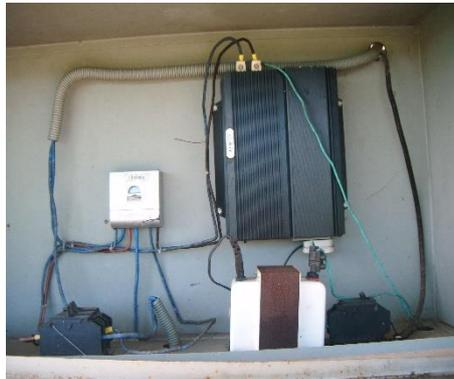
Figura 6 – Controlador de carga Phocos CX inserido no circuito. Fonte: acervo do autor.
