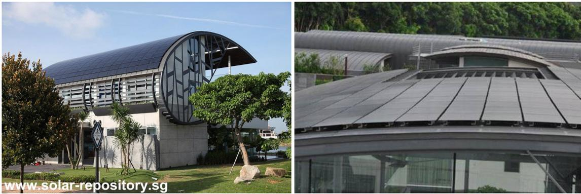
Figura 1 – Sistema fotovoltaico instalado seguindo a cobertura curva da residência em Cingapura. Detalhe para a distância de aproximadamente 10 cm entre os módulos e a cobertura da edificação.
