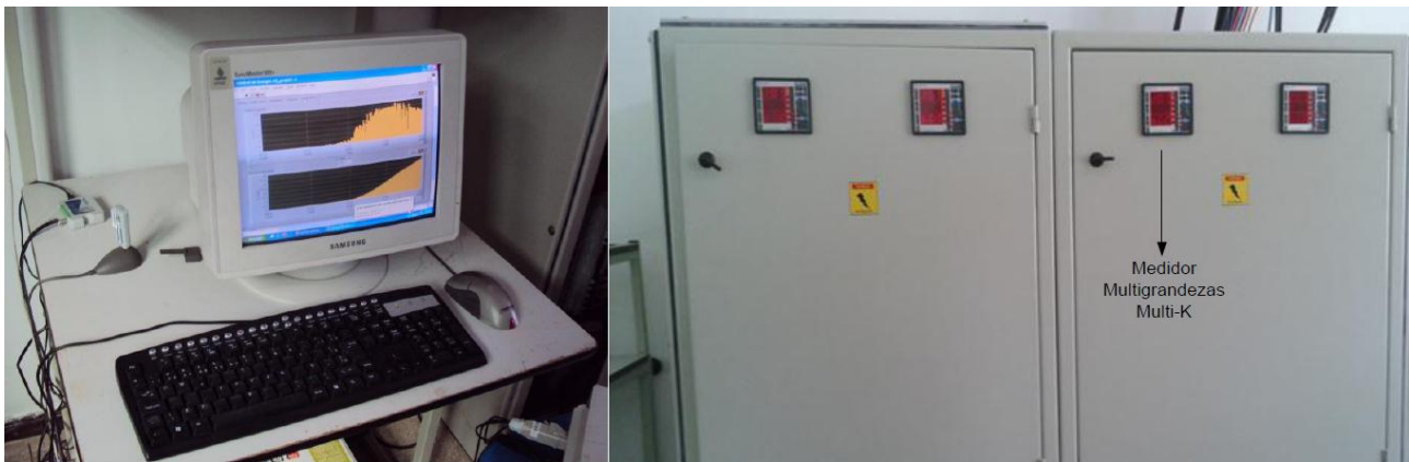
Figura 1 - (a) Computador que gerencia os equipamentos da rede Modbus. (b) Medidores multigrandezas instalados na porta do quadro geral de distribuição da edificação.
