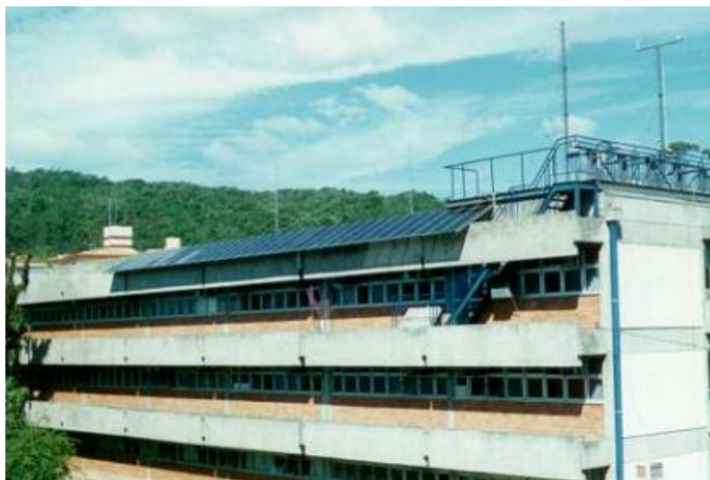
Figura 1 - Primeiro sistema FV conectado à rede instalado no Brasil (1997), com módulos de filme fino de silício amorfo hidrogenado (a-Si:H) integrados a uma edificação.
