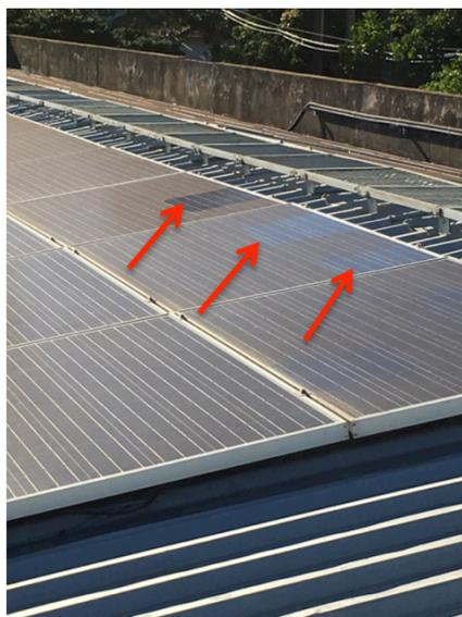
Figura 3: Sujidade depositada sobre os módulos.
