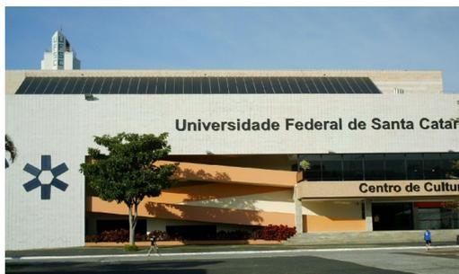
Figura 6 - Sistema fotovoltaico plano inclinado a 27°N, com 10,24 kWp, integrado ao Centro de Cultura e Eventos da UFSC.
