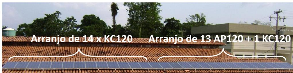
Figura 1- Vista do gerador FV de 3,36 kWp, instalado no telhado da edificação.
