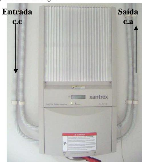
Figura 3- Inversor Xantrex instalado num compartimento interno da edificação.
