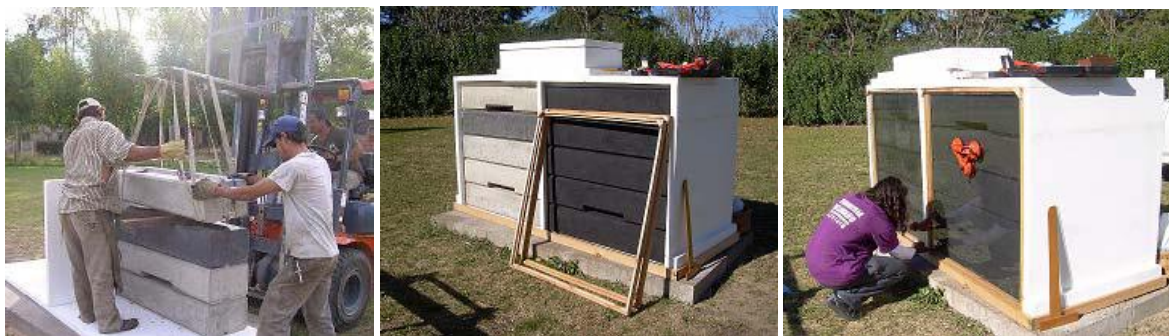
Figura 7- Montaje de los BOX con la instalación completa de ambos MAC y sensores.
