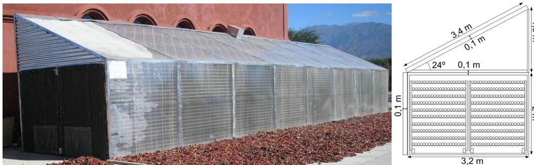
Figura 5: Caras norte y este de la cámara de secado. Se aprecian los colectores solares en techo y pared, y la puerta de entrada de producto fresco. Figura 6: Esquema de sección de la cámara de secado.
