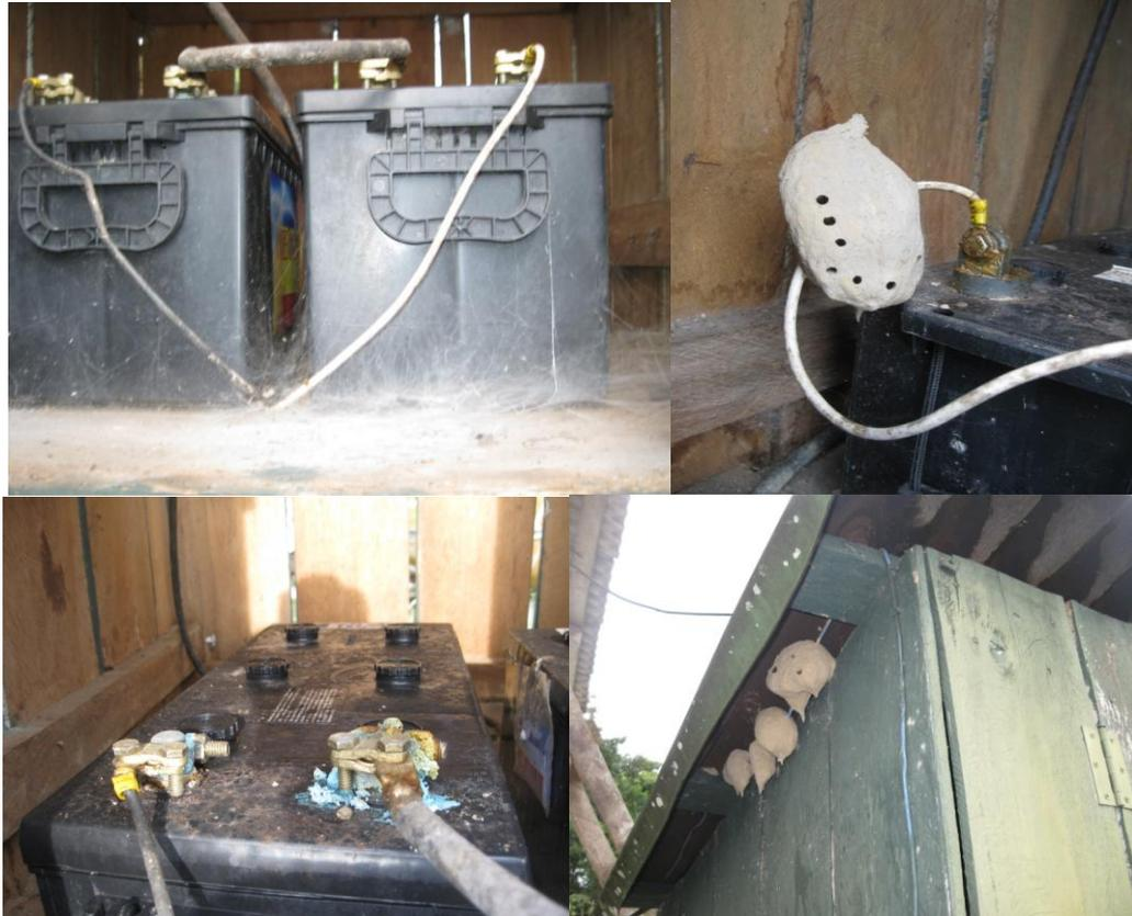
Figura 6 – Problemas com a limpeza dos abrigos e corrosão nos terminais das baterias
