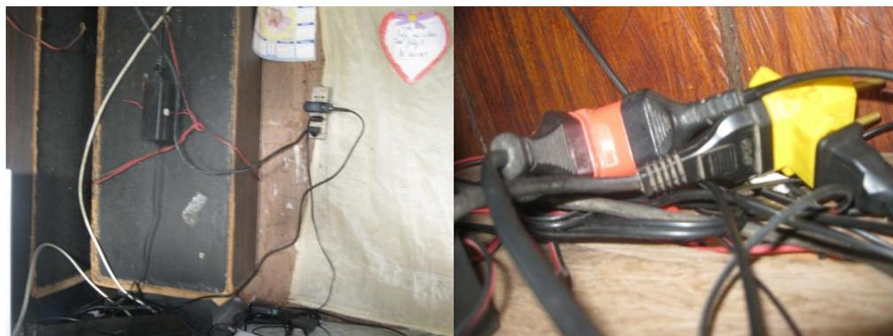
Figura 8 - Uso excessivo de benjamins e extensões.
