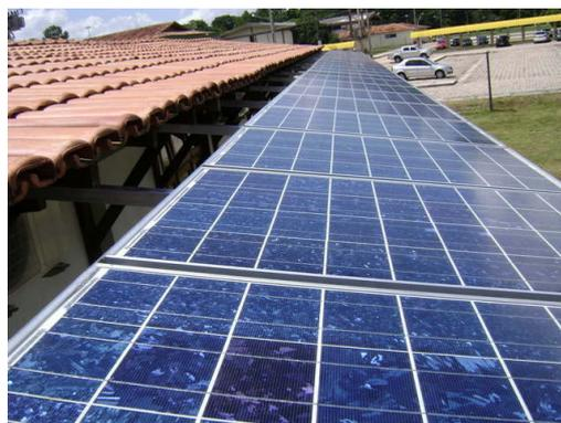
Figura 4 – Sistema fotovoltaico conectado à rede do GEDAE (prolongamento do telhado).
