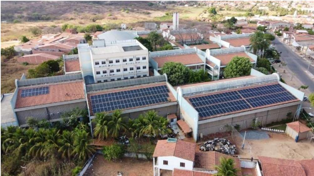
Figura 2 - Vista superior da disposição dos módulos fotovoltaicos.
