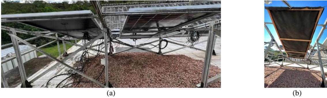
Figura 5 – Face posterior do módulo monofacial à esquerda e módulo bifacial à direita (a), módulo bifacial coberto com anteparo (b).
