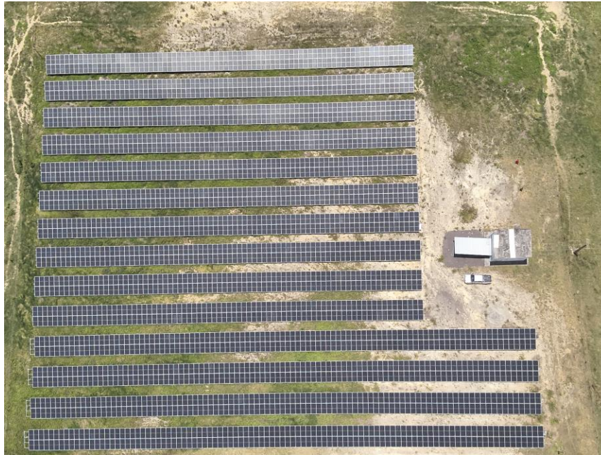
Figura 1 – Usina solar fotovoltaica de 1 MW de onde foram captadas as imagens.
