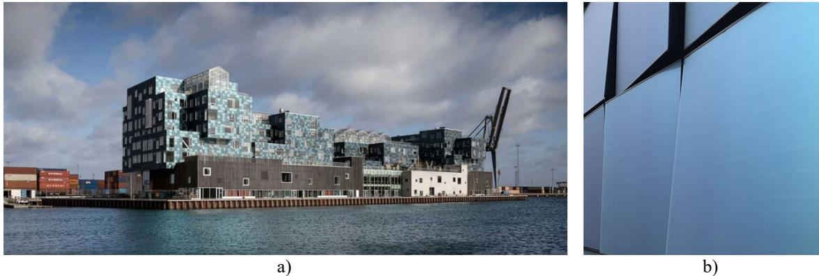
Figura 8 - Edifício CIS, Dinamarca, 2017. a) Visão do conjunto; b) Detalhe da disposição dos painéis fotovoltaicos em *Kromatik Glass* inclinados em diferentes direções. Fonte: <https://www.cfmoller.com>.
