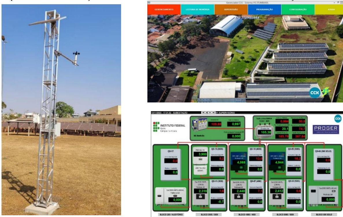
Figura 3 – Estação solarimétrica e interface dos software de medição de geração e consumo de energia elétrica.
