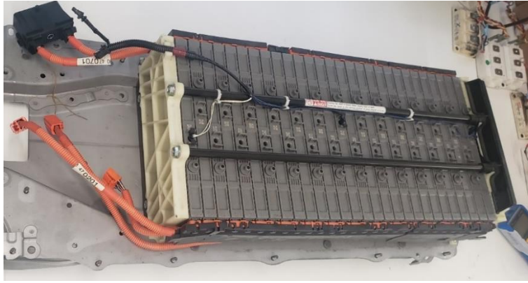
Figura 5 - Bateria sendo desmontada na bancada.
