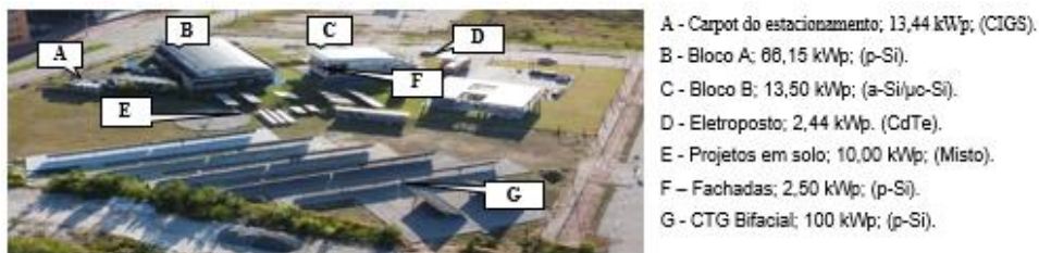
Figura 1 – Vista aérea do Laboratório FV UFSC
