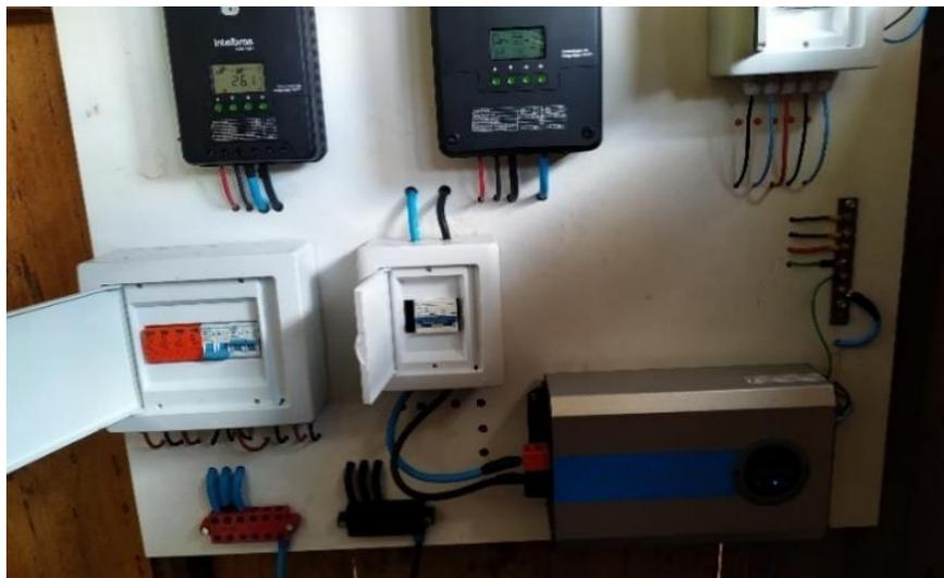
Figura 6 – Quadro de Comando da Usina Fotovoltaica.
