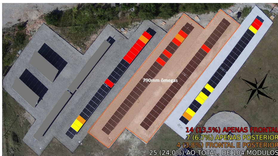
Figura 16 – Imagem aérea da usina FV destacando os módulos trincados analisados na Fase 2 deste estudo de caso. Os rastreadores com correia de suporte ômega mais curtos são indicados na imagem.
