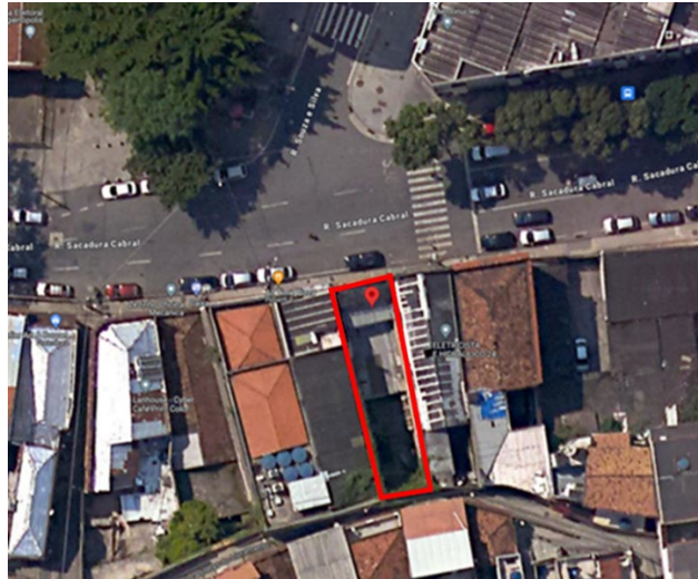
Figura 2 – Imagem da edificação
