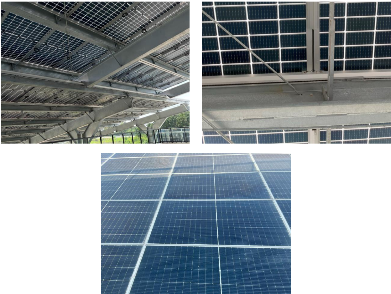
Figura 3 – Sistema de vedação estanque das coberturas FV C1 e C2 do Bloco C do Laboratório Fotovoltaica/UFSC.
